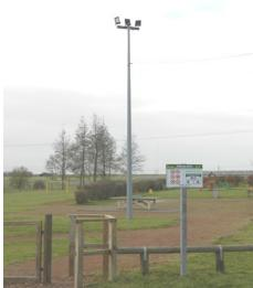
L'éclairage public de l'aire de jeux dysfonctionnait et méritait une réflexion sur les zones d'ombres de la rue des Processions. Nous avons ainsi procédé à l'installation d'un nouveau matériel équipé de projecteurs LED de nouvelle génération en basse consommation. Les derniers réglages (notamment de minuterie) interviendront très prochainement.
